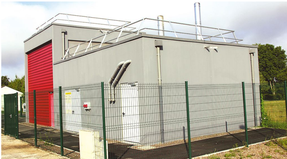
Opérationnelle depuis novembre 2014, la chaufferie de Gy alimente le complexe sportif, le collège Raymond-Gueux et le futur pôle éducatif.
