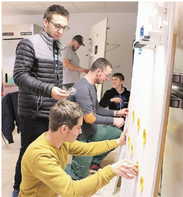
Installation électrique avec Rémi Ducheine.
