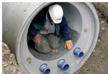
Figure 65. Canalisation préfabriquée avec échangeur de chaleur intégré (Guide pour les maîtres d'ouvrages et les communes, OFEN)
